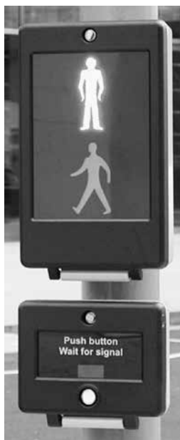
Панели управления «паффин-переходом»
