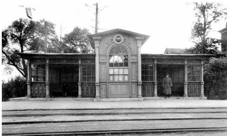
Трамвайная остановка «Красностуденческий проезд». Москва, 1950-е гг.
