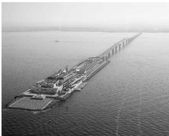
Туннель Tokyo Bay Aqua-line в Кавасаки. Япония
