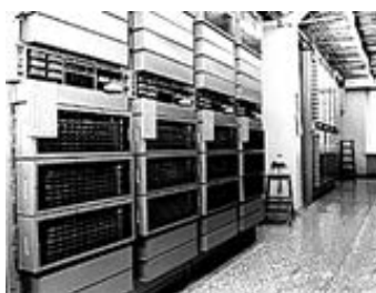
Рисунок 10.3.5 — Автоматические телефонные коммутаторы: а) станив механоэлектронной АТС; б) станив квазиэлектронной АТС
