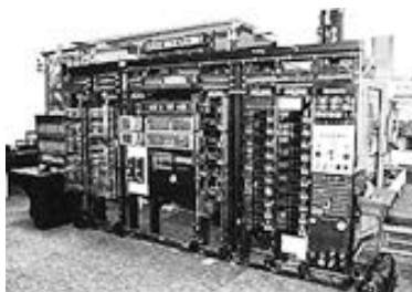
Рисунок 10.3.5 — Автоматические телефонные коммутаторы: а) станив механоэлектронной АТС; б) станив квазиэлектронной АТС
